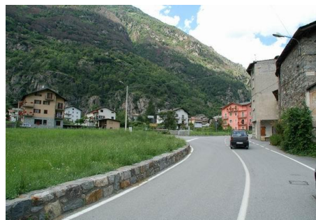
Foto 12 - Edifici in via Casale Stanga
